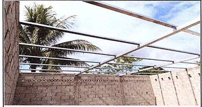
Foto 2: Continuación de la reparacion y cambio del techo de la cocina del edificio escolar
